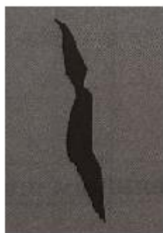
Заполнение трещины подмазочной пастой
