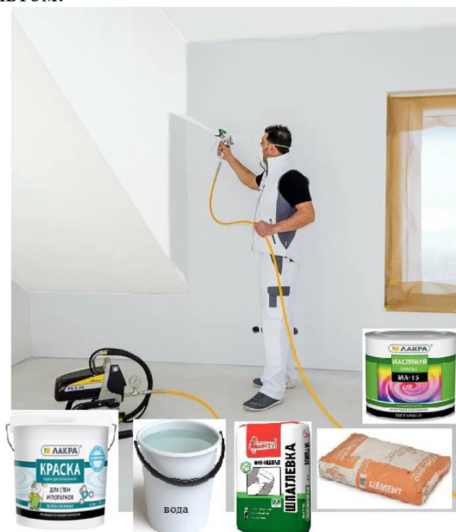
Рис. 2.2.2. Окрашивание стен помещения
